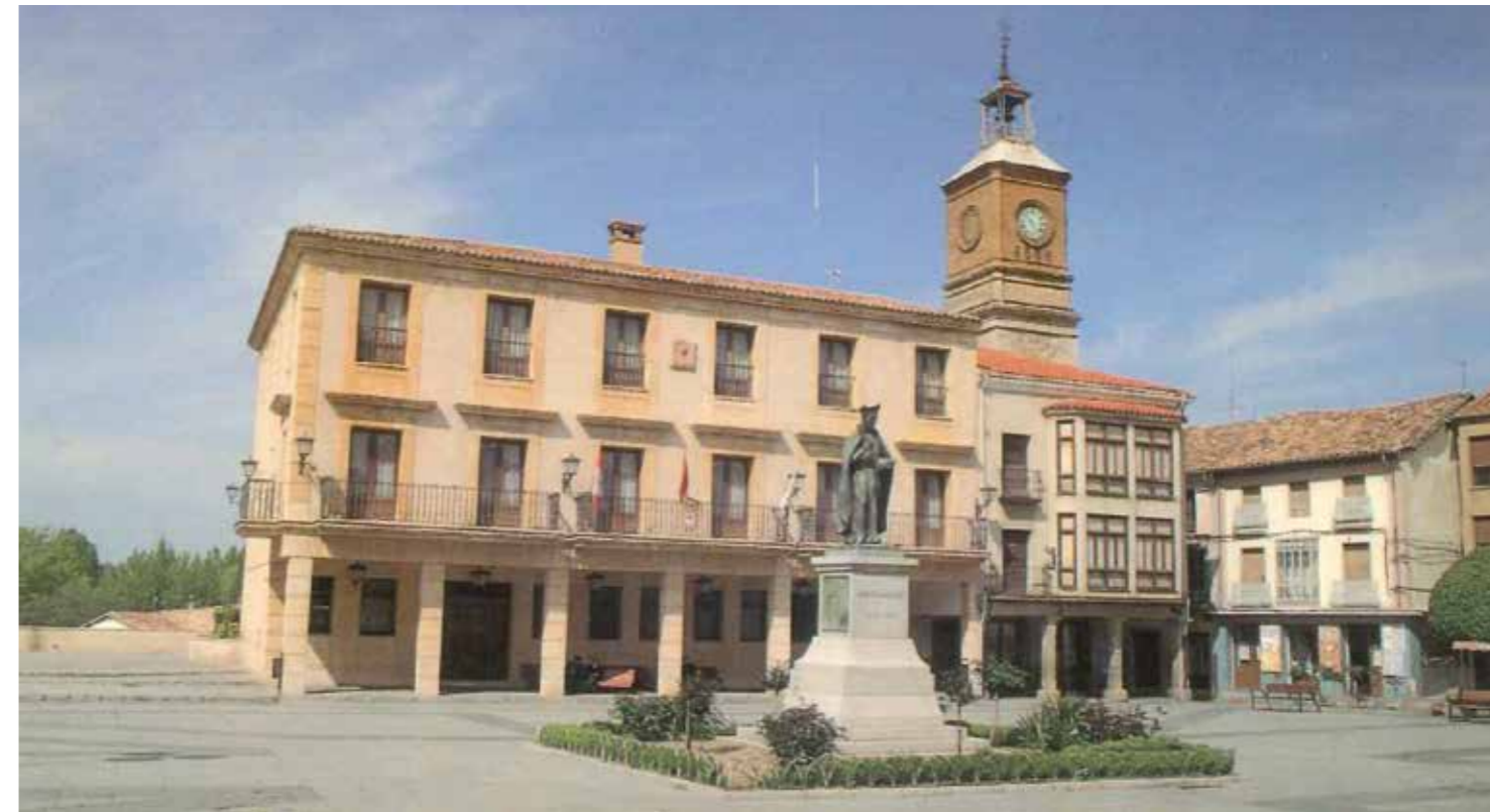
EDIFICIO CONSISTORIAL CONSTRUIDO EN 1982 - 1984
